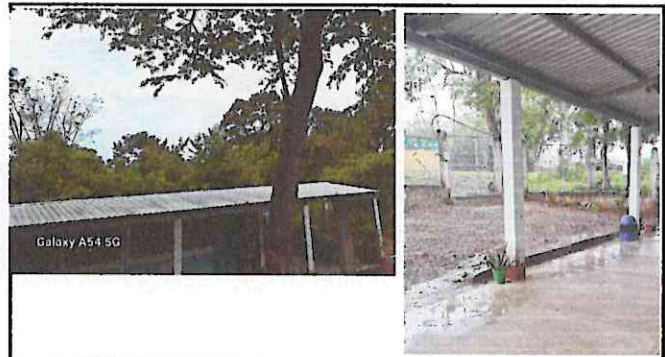
Foto 2: Colocación de canales en las caldas de agua del establecimiento, pues en temporada de lluvia, se entra el agua llovediza al corredor.
