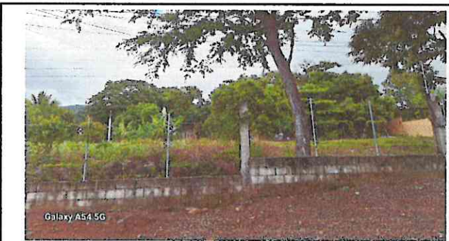
Foto 3: Mejoramiento del muro perimetral del establecimiento educativo, para mayor seguridad ya que se encuentra en malas condiciones.
