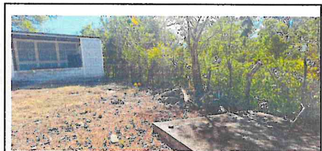
Foto 4: Continuación de circulación del área de atrás del centro educativo, para una mayor seguridad.
